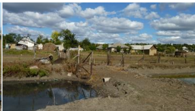
Im.59: un baraj folosit ca pod și pentru a reține apa pe râul Ciulucul Mic, s. Bursuceni (r-nul Sângerei). Se vede că țeava e mai sus nu doar decât nivelul apei, dar și în principiu decât nivelul solului
