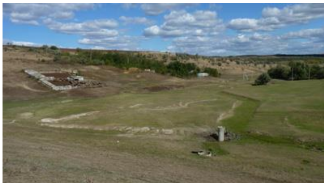
Im.56: lunca și albia uscată a râului Ciulucul Mic – privite de pe digul unui iaz mare care nu dă drumul la apă, s. Pietrosu (r-nul Fălești)
