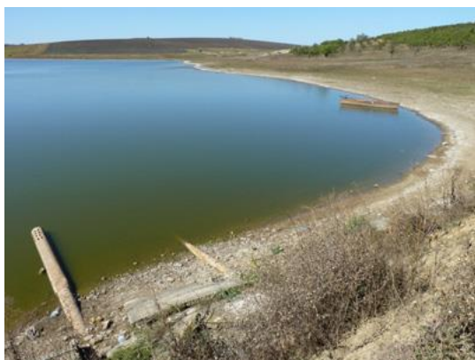
Im.14: unul dintre iazuri din s. Glinjeni (r-nul Făleşti), aflat pe cursul râului Ciulucul de Mijloc. Se văd țevile folosite pentru transferarea apei în iazuri piscicole aflate alături, care nu deversează apa în râu.
