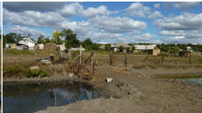
Im.51: un baraj folosit ca pod și pentru a reține apa pe râul Ciulucul Mic, s. Bursuceni (r-nul Sângerei). Se vede că țeava e mai sus nu doar decât nivelul apei, dar și în principiu decât nivelul solului
