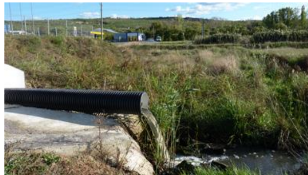
Im.39: deversarea apelor uzate tratate de la stația de epurare din or. Telenești
