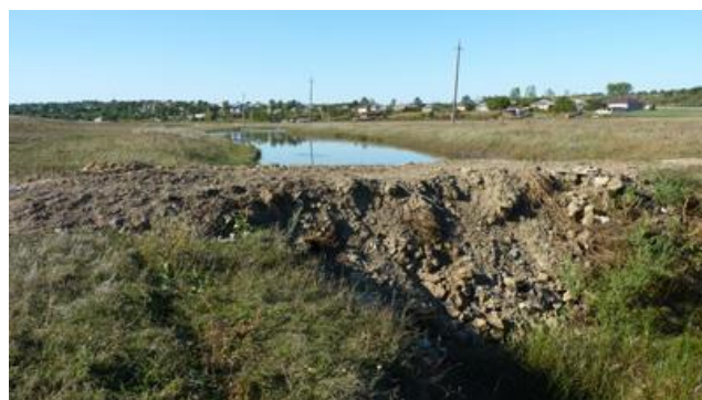
Im.53: ultimul din seria de baraje din satul Biliceniei Vechi (r-nul Sângerei). Se observă diferența nivelurilor, lipsa scurgeri și faptul că după baraj râul – Ciulucul Mare – demult n-a curs.
